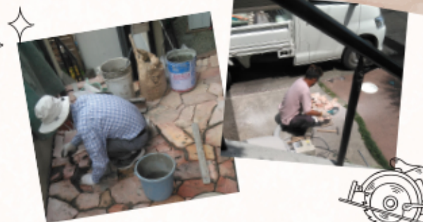
【乱形石貼りの床】大小さまざまな形の石をパズルのように組み合わせ、一枚一枚丁寧に据えています。職人技が光る施工法です。
